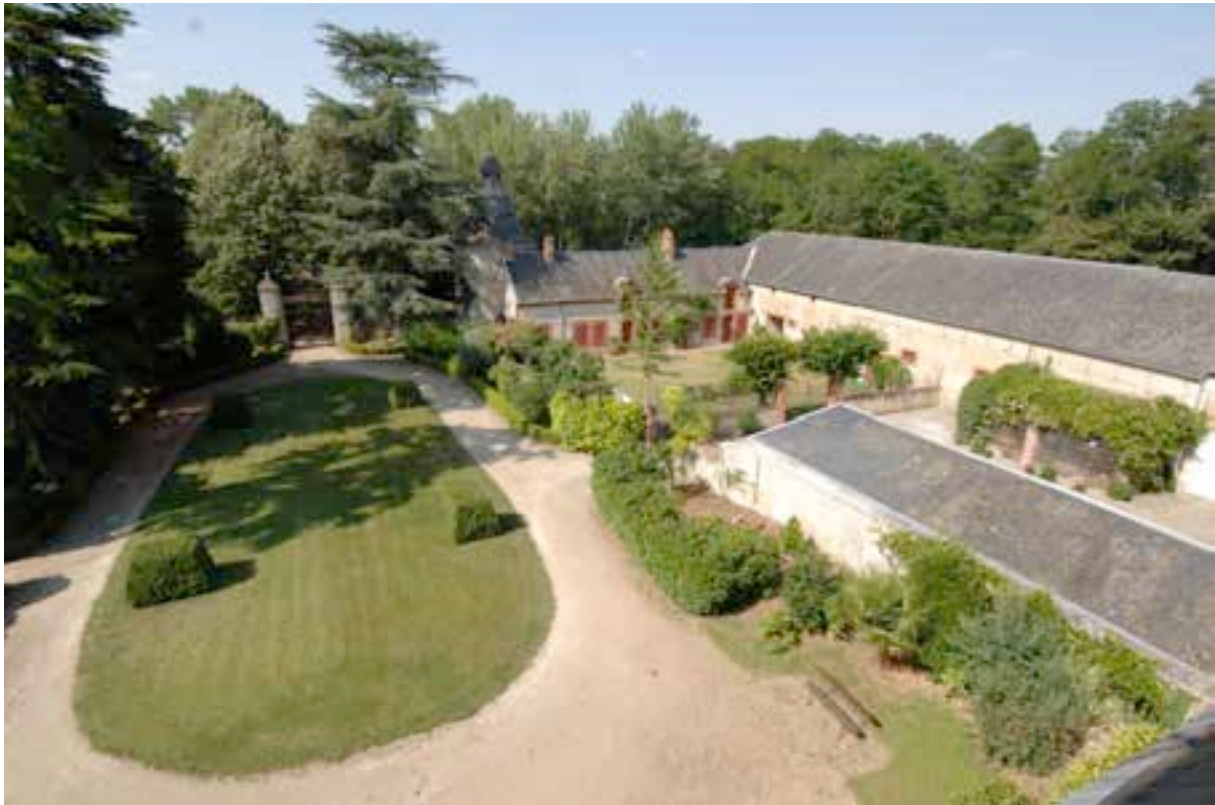
La vue des communs depuis les combles
